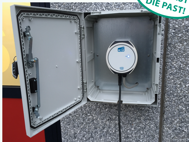
3-PUNTSSLUITING ophanging buiten afdichting afwatergaten
