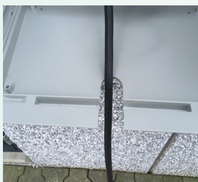
STANDAARD UITSPARING voor laadkabel doorvoer
